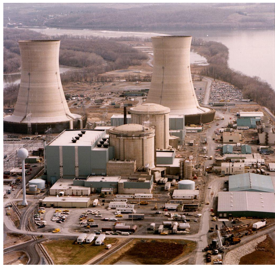
スリーマイル島原子力発電所。中央手前の二つのドームが原子炉建屋で、その左隣の白い建物が制御室を含むタービン建屋である。奥に見える二基の塔状構造物は放熱塔。
