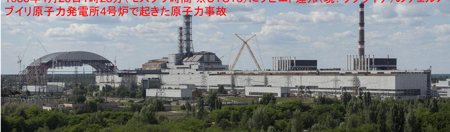
旧チェルノブイリ発電所のパノラマビュー(2013年6月) 左側からNSCの半分(リフト作業中)、4号機、3号機、2号機、1号機
