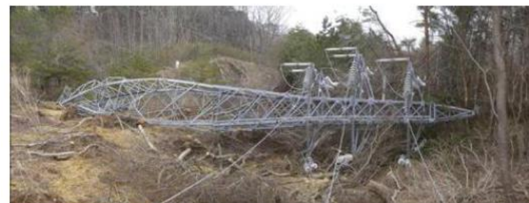
写真 土砂崩壊による夜の森線鉄塔の倒壊
