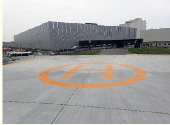
<ヘリポート(新事務本館入口近傍)>
