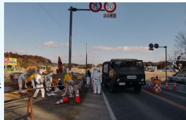
道路陥没箇所応急措置(手伝い)
