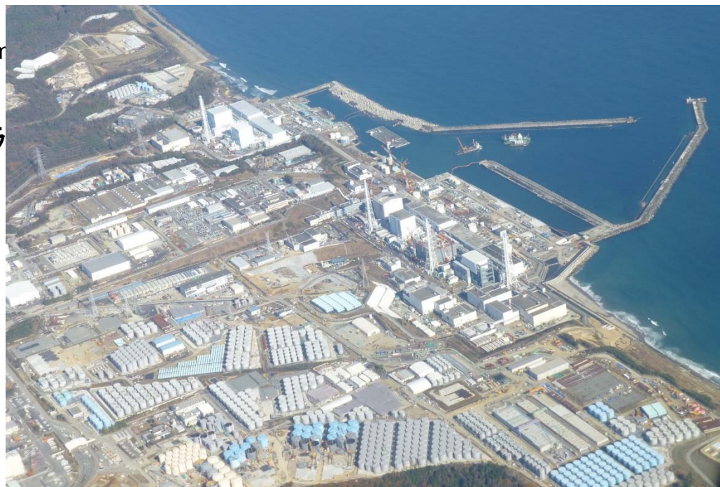
福島第1原子力発電所における汚染水タンク設置状況
